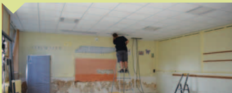
ÉCOLE ROSTAND : réfection des salles de classe
